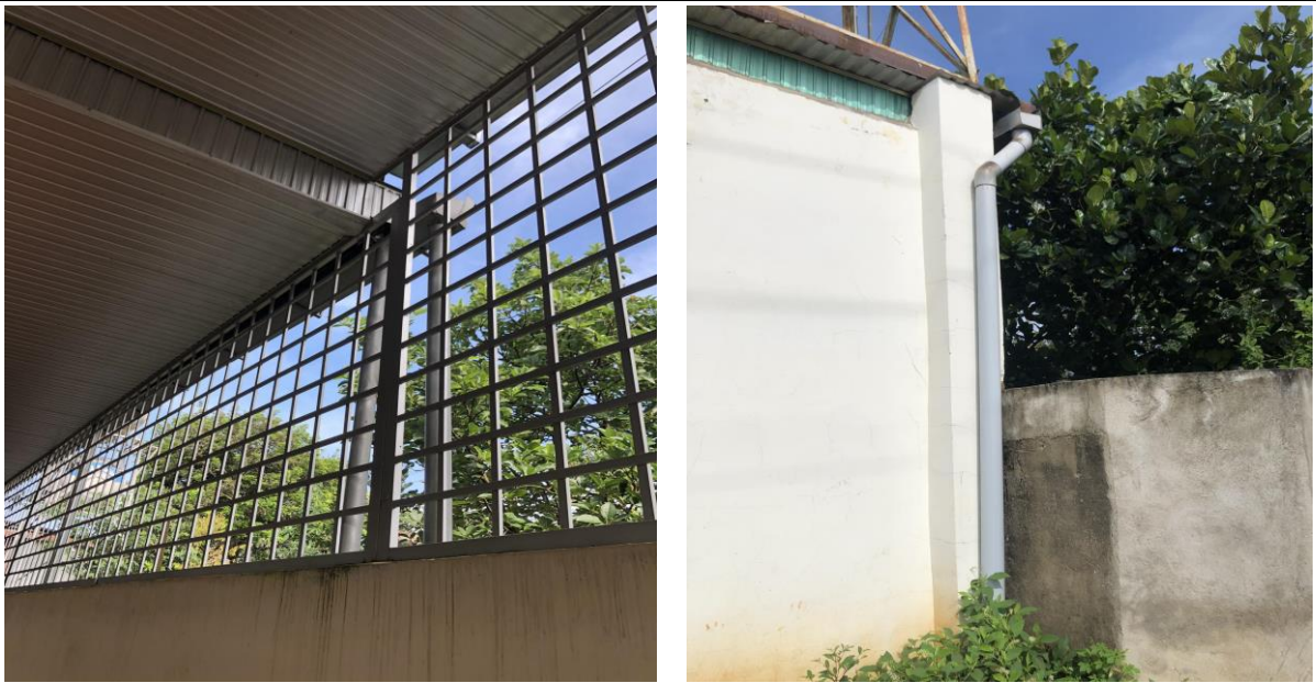
Hình 3.2. Hiện trạng thu gom nước mưa tại nhà máy
